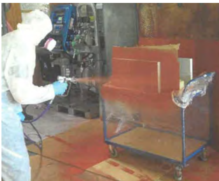
Nakładanie natryskowe membrany MasterSeal M 790 w pozycji poziomej
