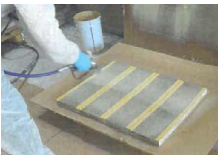
Nakładanie natryskowe podkładu MasterSeal P 770
